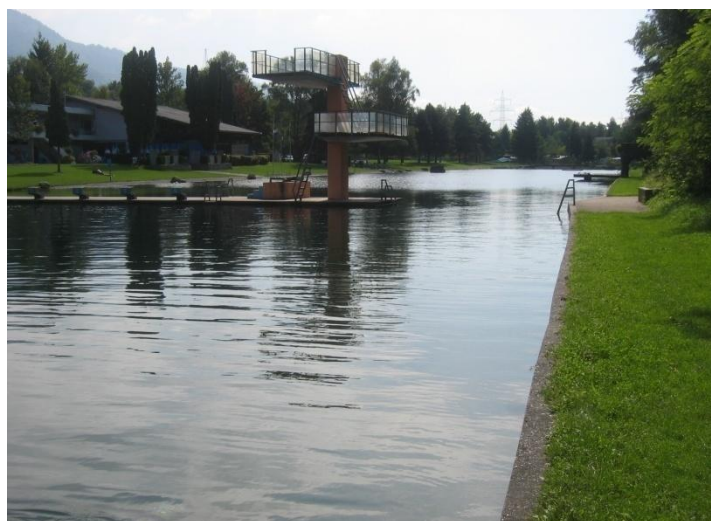
Abbildung 8: Das Schwimmbecken im Strandbad
